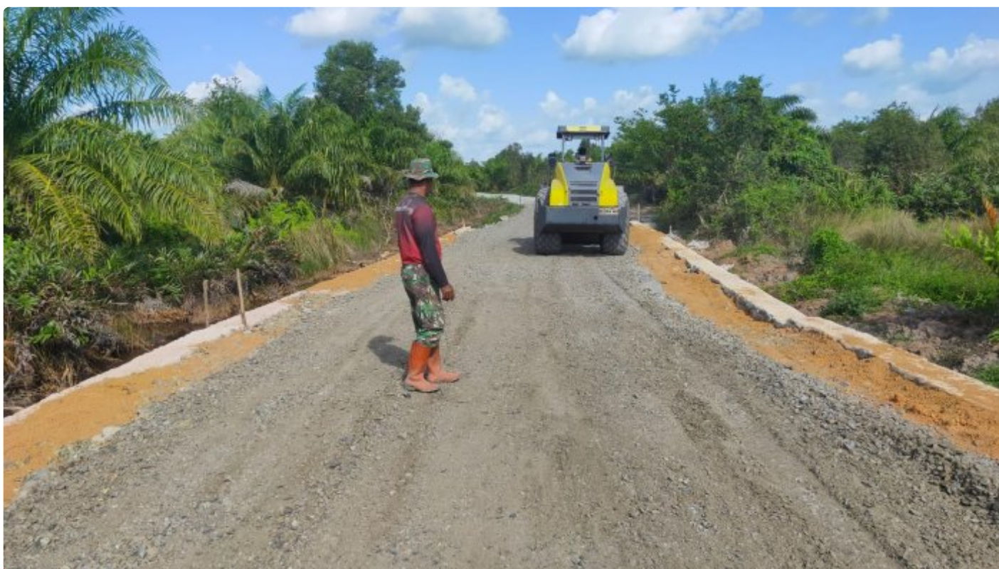
Percepat Pekerjaan, Vibro Dan Grader Dikerahkan Di Sasaran Pokok TMMD
