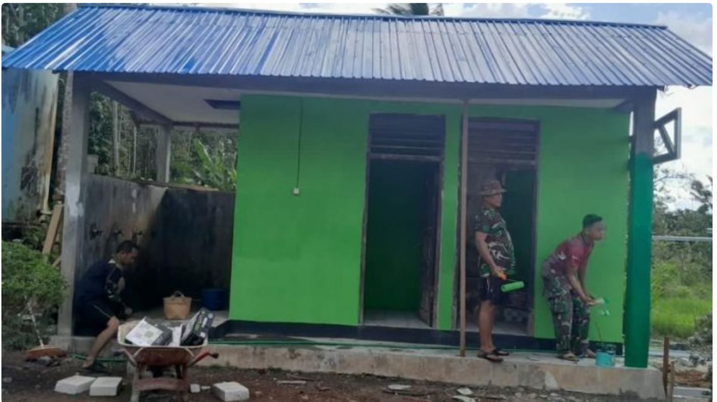
Pengerjaan Sasaran Rehab Masjid, Tinggal Finising
