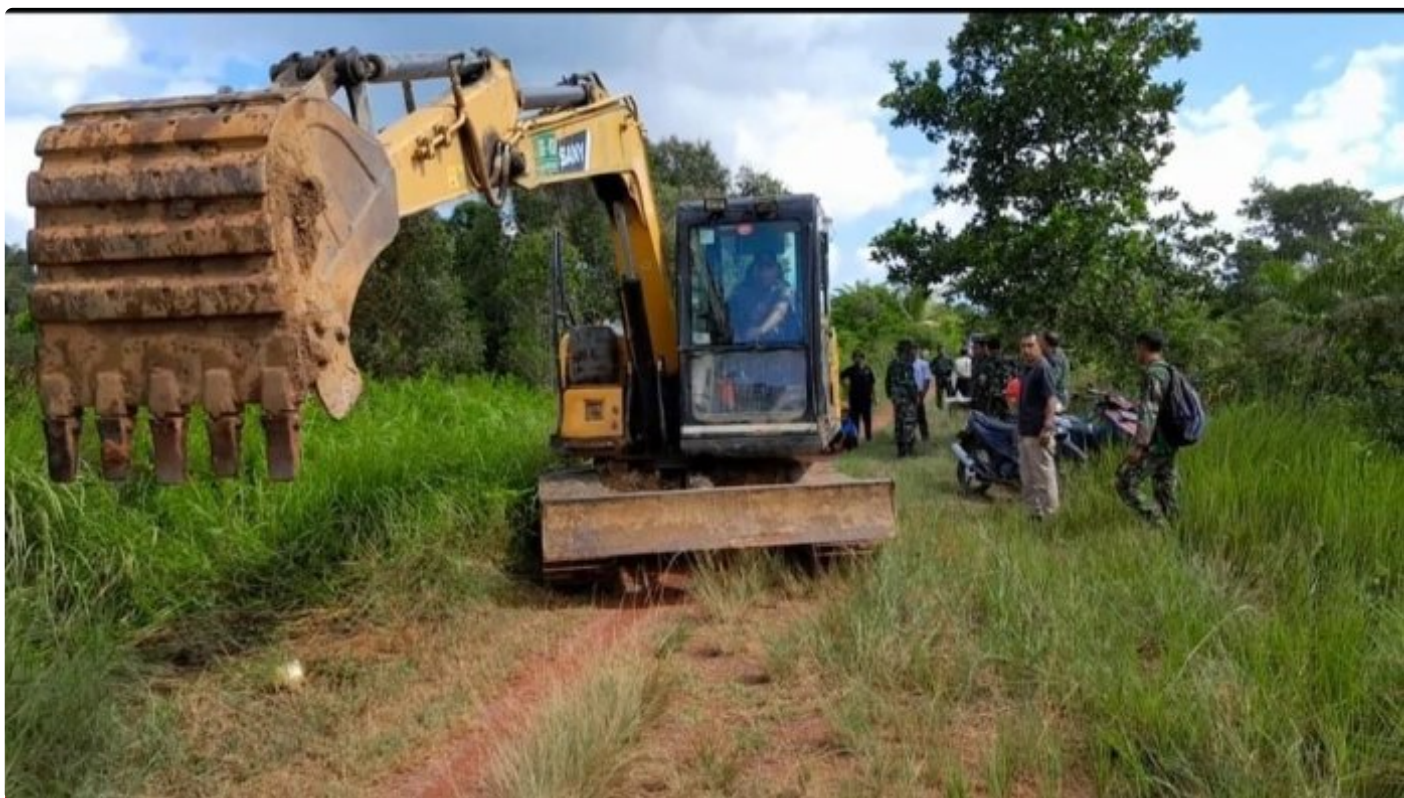
Dandim 1009/Tla, Turunkan Excavator Di Lokasi TMMD
